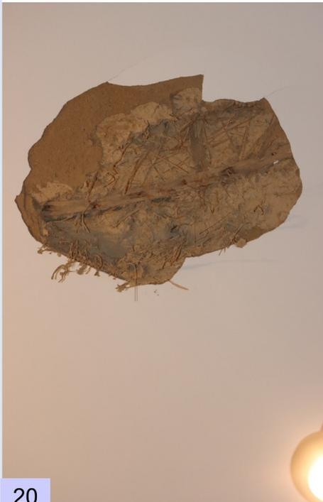
überlaufen und in die Lehmdecke eindringen. So war dann ein ca. 80 cm großes Stück Lehmdecke herausgebrochen und abgestürzt. Normalerweise befindet sich eine Heizleitung bis zum Dachaustritt in diesem Rohr um ein Einfrieren zu verhindern. Wieso diese aber zu kurz verlegt war, kann im Nachhinein nicht mehr festgestellt werden. Nun muss die Decke erst wieder richtig abtrocknen. Sie soll dann im Sommer repariert werden.
